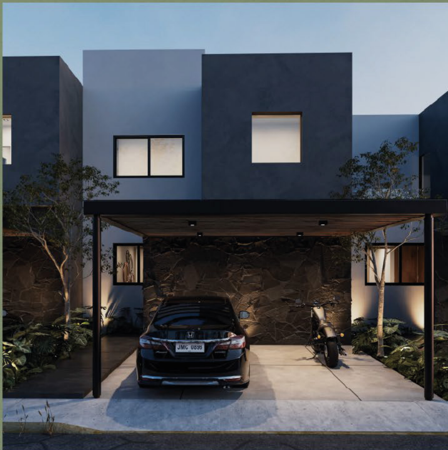
Fachada frontal de noche
